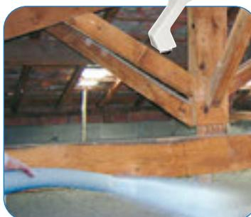
◀ REMPLISSAGE de comble avec de la ouate de cellulose
